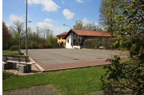
Blick auf die vorhandene Stockbahn und das Ver- einsheim. Im Hintergrund Teil der Mischgebietsbe- bauung.
