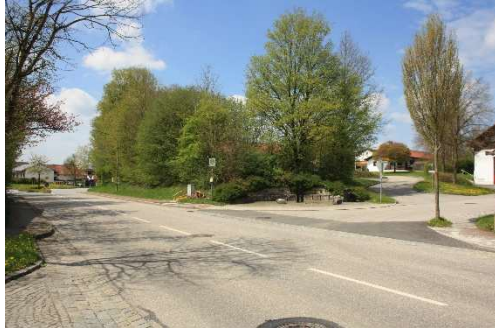
Rechts Einmündungsbereich der Arberstraße.
