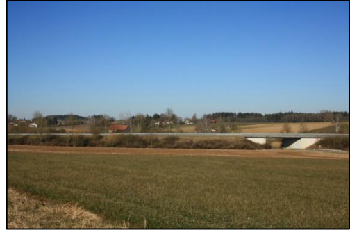
Planungsgebiet (Blickrichtung nach Nordenwesten)
