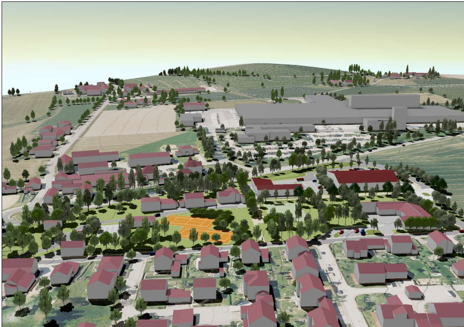
Abbildung: Blick aus Norden auf das Untersuchungsgebiet in der Bildmitte. Diagonal verlaufend die Bundesstraße 299; dahinter anschließend die Fa. Bulthaup. KomPlan.
